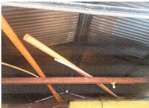
Foto 3: Cambio de estructura y láminas del techo de la cocina
