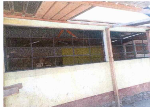
Foto 4: 3 balcones y 1 ventana de la cocina
